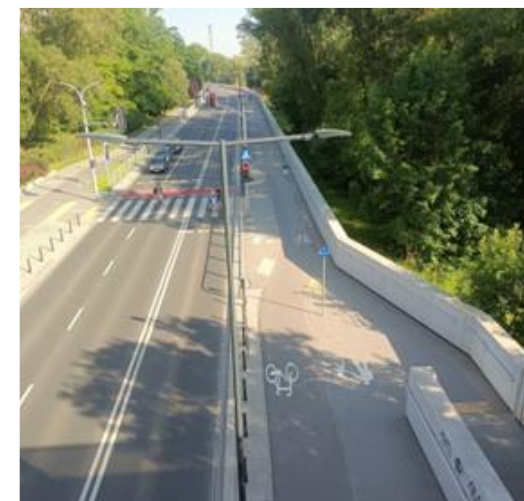
Rys. 5.19 Droga dla rowerów i ciąg pieszy w pasie drogowym w Warszawie
