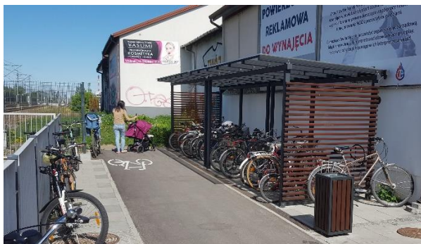
Rys. 7.2 Zadaszony parking B+R w Wołominie
