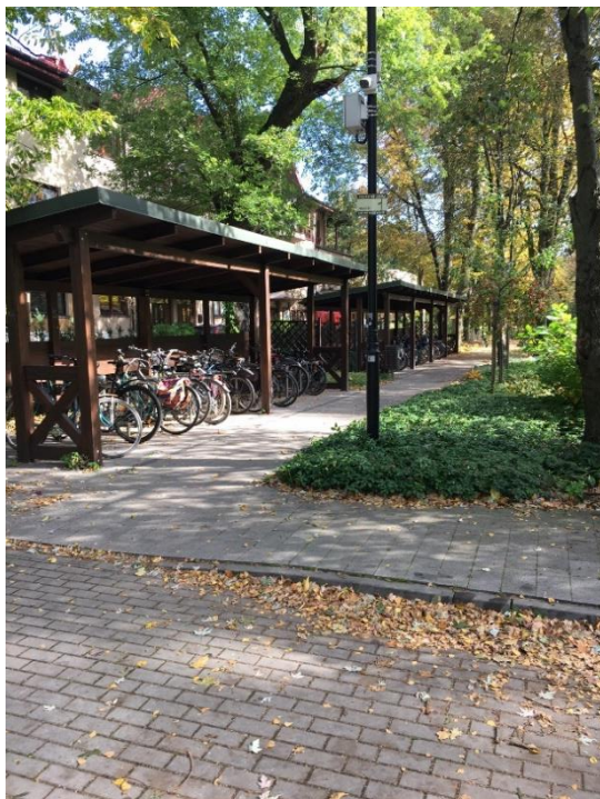
Rys. 2.4 Zadaszony parking B+R w Podkowie Leśnej
